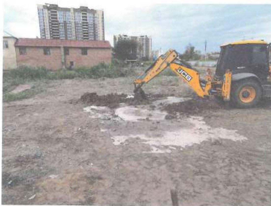
Рис. 16. Процесс рекультивации шурфа. Вид с востока.
