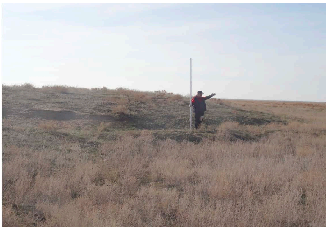
Рис. 240. Траншея водогона на СВ склоне кургана №2. Вид с востока.
