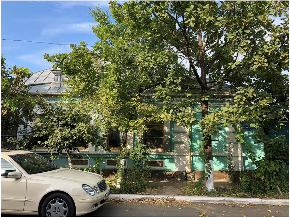
Вид на главный фасад Объекта по улице Бабушкина.
