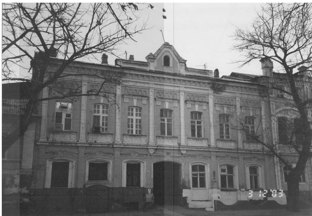
Фотографии 2003 г. Главный западный фасад вдоль улицы М. Горького. Цоколь выкрашен в разные цвета. По обе стороны от обрамления чердачного окна сохранились следы креплений вазонов (?)
