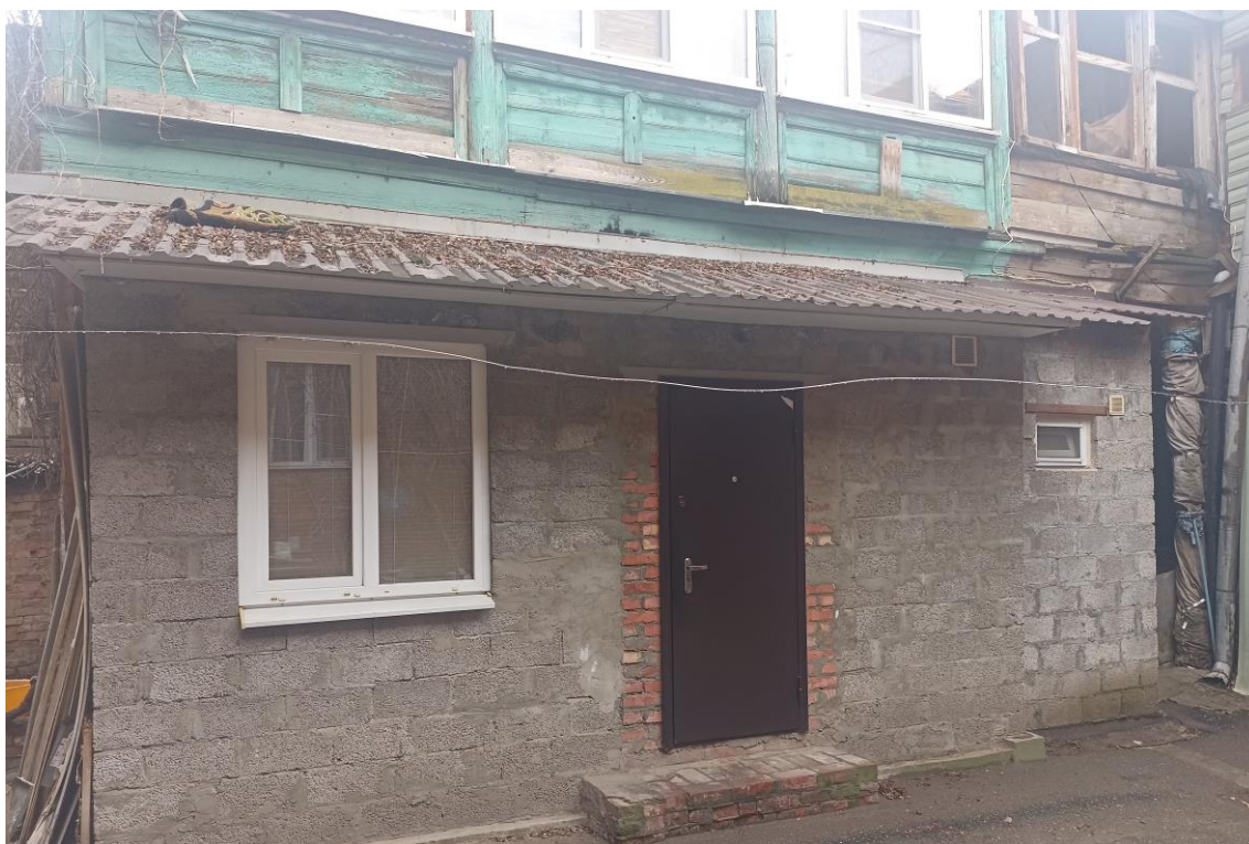
«Дом жилой с лавками», кон. XIX в. – г. Астрахань, ул. М. Горького, 43. Фото № 6. Пристрой из керамзитобетонных блоков к дворовому крылу лит. «А». Фото: Горлов Г.В., февраль 2025 г.
