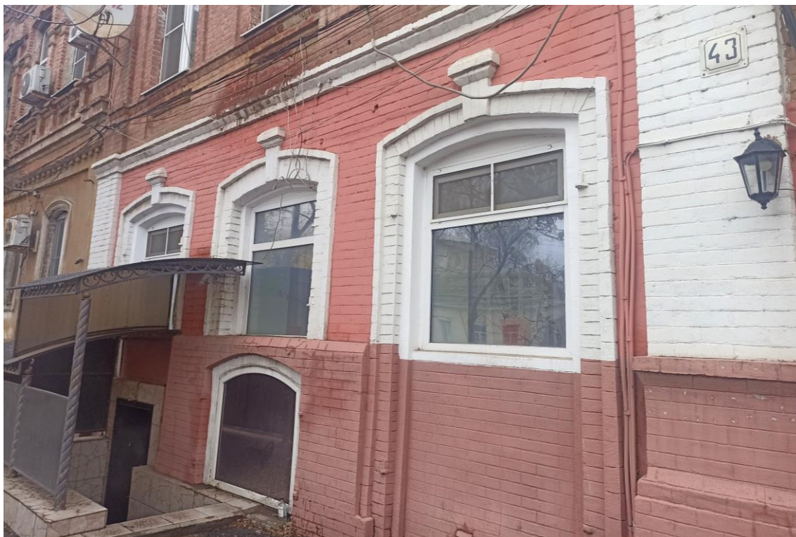
«Дом жилой с лавками», кон. XIX в. – г. Астрахань, ул. М. Горького, 43. Фото № 3. Главный северо-западный фасад лит. «А» (ул. М. Горького). Устройство приемка со входом в подвальное помещение. Фото: Горлов Г.В., февраль 2025 г.
