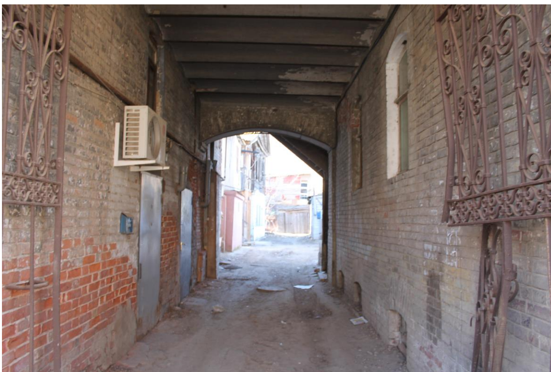
«Дом жилой», кон. XIX в. – г. Астрахань, ул. Сен-Симона, 22. Фото № 6. Главный юго-восточный фасад Объекта (ул. Сен-Симона, лит. «Б»). Перекрытие проездной арки сводами «Монье». Фото: Горлов Г.В., март 2025 г.
