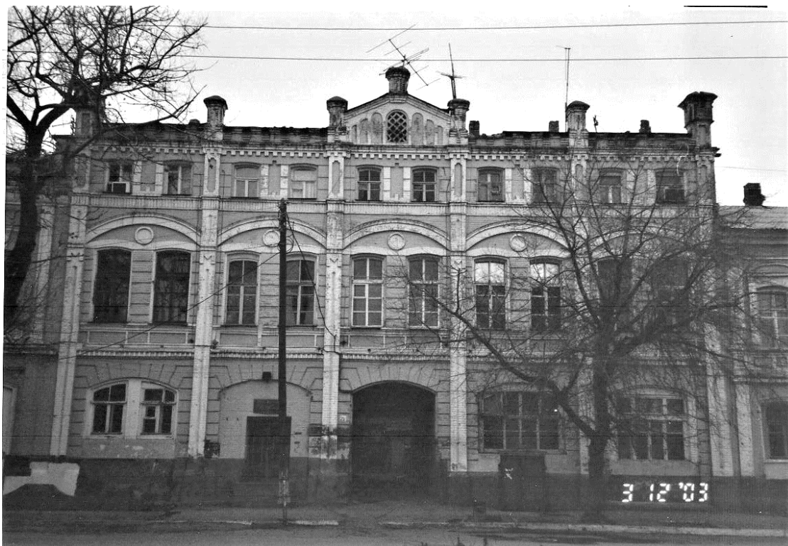
Фото 2003 г. Левое лучковое окно лавки поделено кирпичным импостом, «выход» подокном заложен. Правая широкая дверь стала зауженным окном с пластиковым к 2011 году переплетом.
