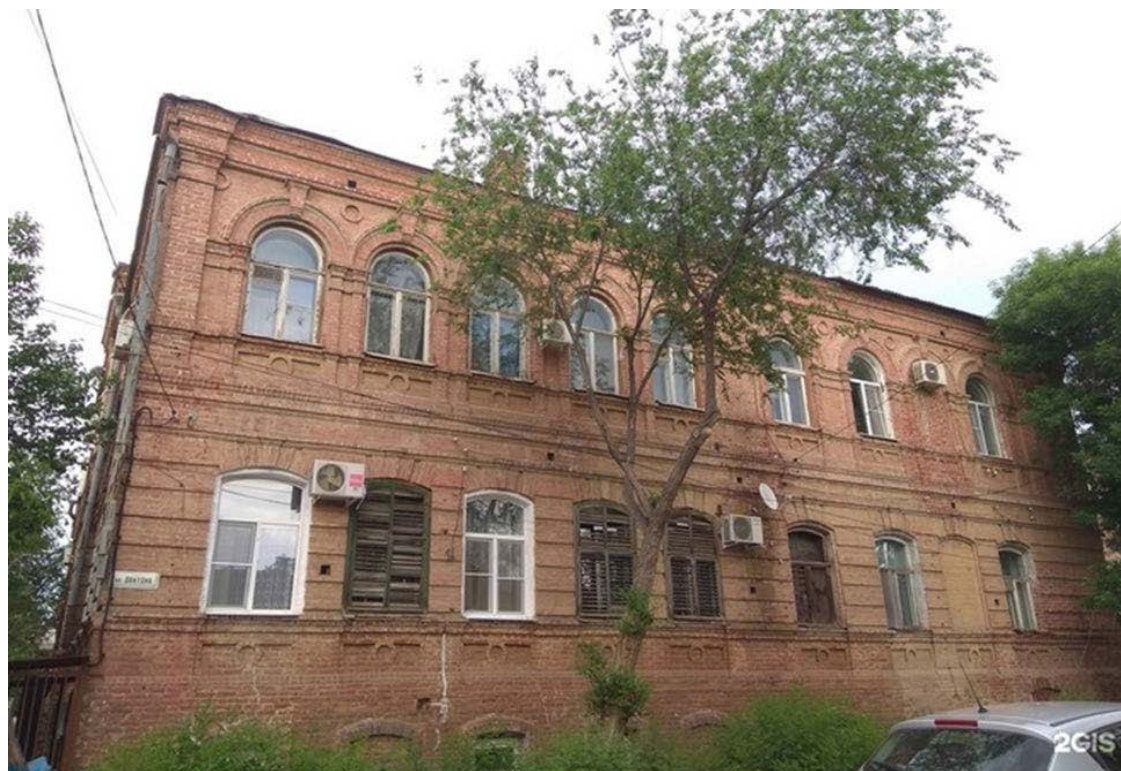
2019 г. Фасад по ул. Дантона.
